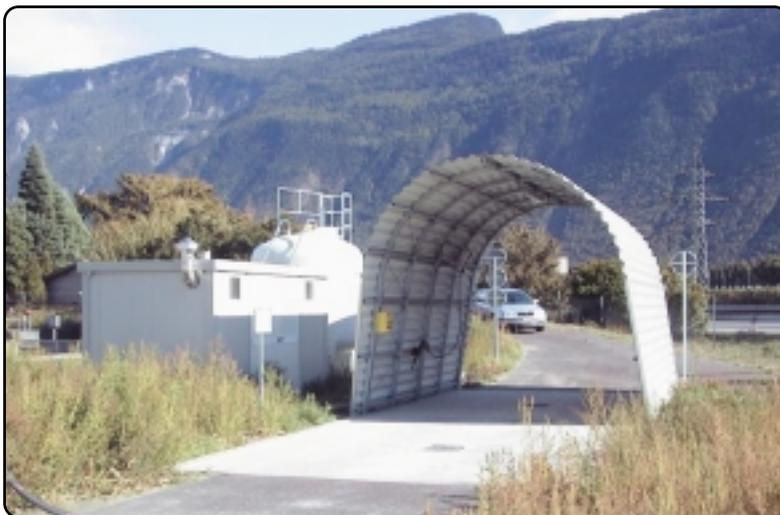
■ Le poste de lavage doit être muni d'une centrale à haute pression, d'une aire bétonnée inclinée, d'un écoulement, d'une citerne récupérant les eaux contaminées et d'un bac de décantation. Les eaux usées décantées peuvent être canalisées vers une station d'épuration ou être traitées séparément.
