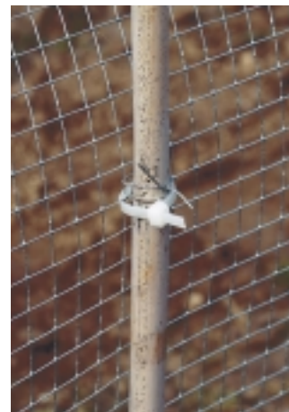
Fig. 4. Fixation du treillis aux piquets.
