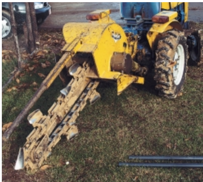
Fig. 7. Appareil à creuser des tranchées pour poser une barrière à près de 50 cm de profondeur.
