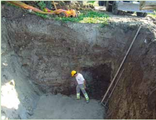
Figure 2 | Des travaux importants ont été nécessaires pour enterrer les cuves.
