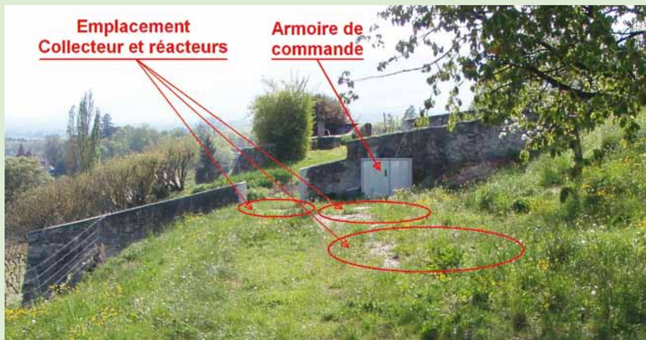
Figure 1 | Toutes les cuves de la STEP sont enterrées, limitant l'emprise sur le paysage.
