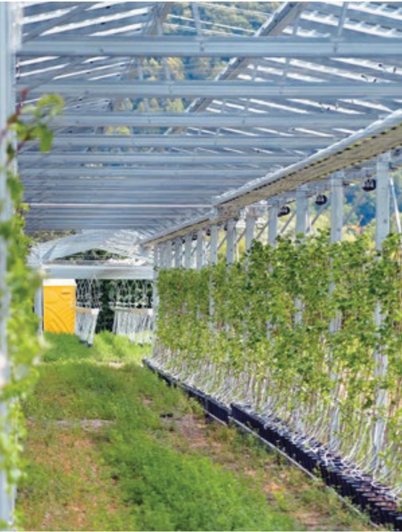
Nouvelles installations en fin de construction à Agroscope-Conthey. Photo : N. Messieux / AMTRA.
