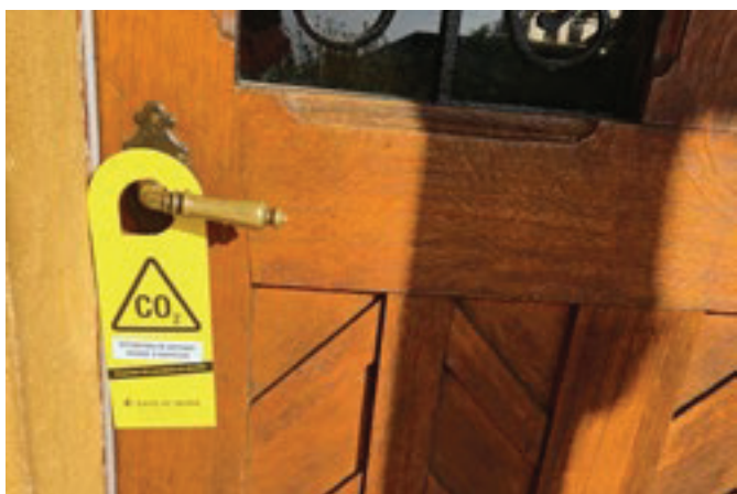
Crochet à suspendre à une poignée de porte, pour avertir de la présence de CO 2 dans la cave. Photo: AMTRA.
