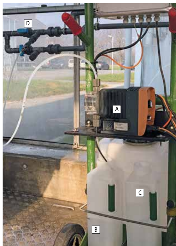
Figure 1 | Système d'injection utilisé dans les essais constitué d'une pompe volumétrique (A), d'un bac pour la bouillie (B) et pour le rinçage des tuyaux (C). Point d'injection dans le tuyau du système d'irrigation (D).
