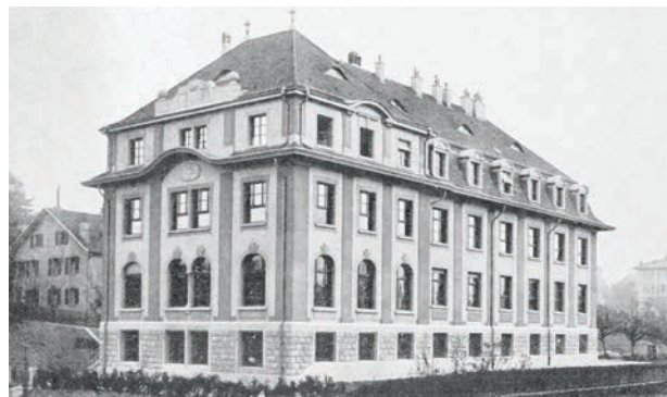
Figure 2 | Bâtiment de l’établissement fédéral de contrôle des semences et d’essais viticoles, arboricoles et de chimie agricole de Montagibert, à Lausanne, actuellement Centre hospitalier universitaire (CHUV).
