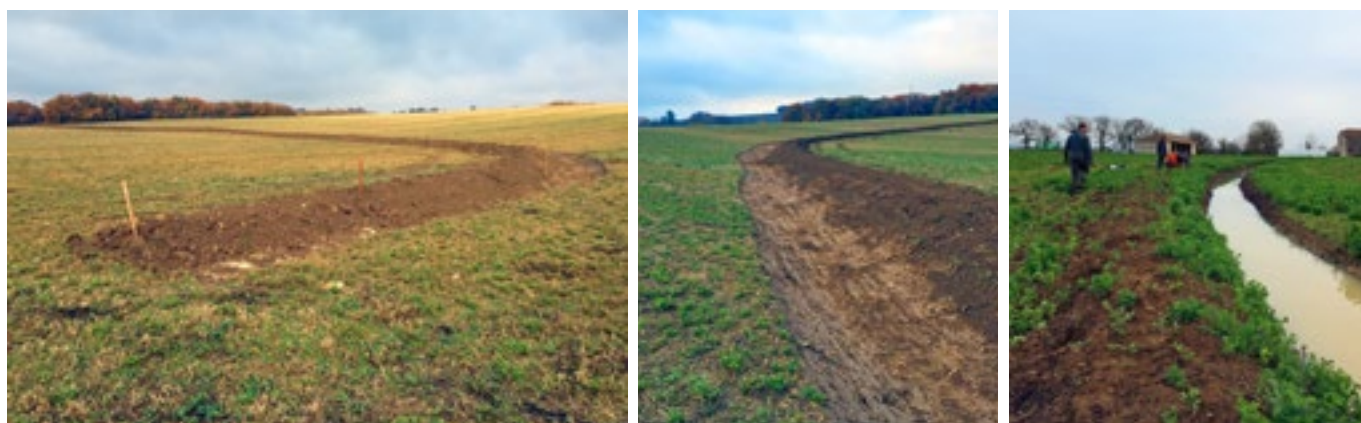
Fig. 1: Les noues au domaine d'Arton (Gers) : réalisation des noues en suivant les courbes de niveau pour capter, étaler et infiltrer les ruissellements, puis introduire la biodiversité dans les parcelles. Préparation de la plantation de 2022 (photos Nicolas Pinto, A. Malard 2021).
