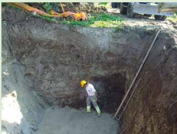
Figure 2 | Des travaux importants ont été nécessaires pour enterrer les cuves.
