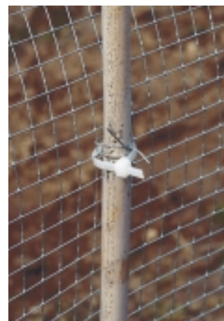
Fig. 4. Fixation du treillis aux piquets.
