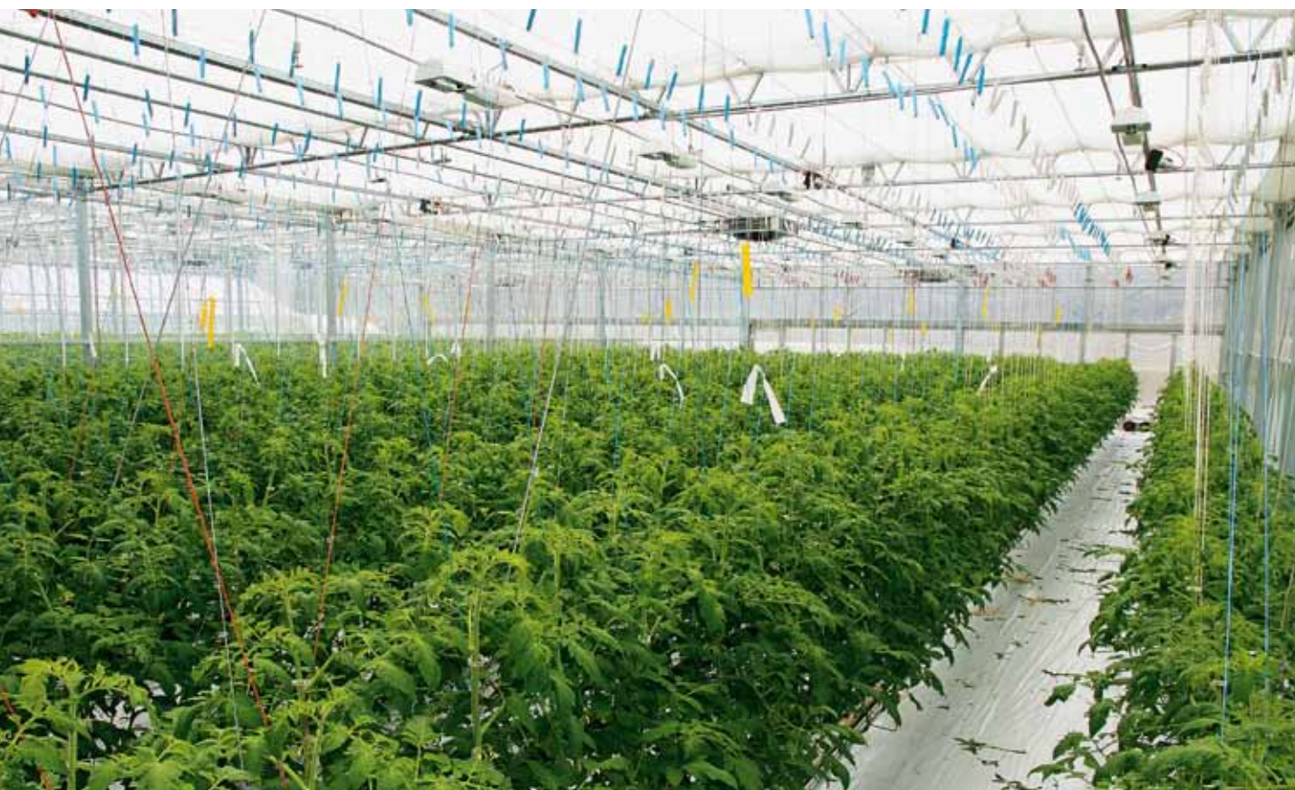
Vue du compartiment test, avec l'écran thermique amovible en toiture destiné à limiter les pertes de chaleur dans la serre.
